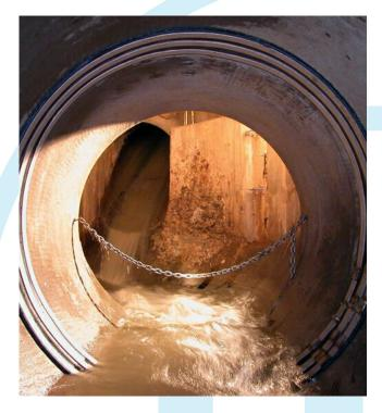
AMEX-10 è un sistema efficace ed economico per risanare dall'interno tubazioni con diametri a partire dal DN 500/600 fino al DN 8000 ed oltre, con pressioni d'esercizio fino a 20 bar.
