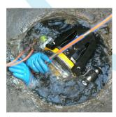
SIGILLATURA SUBACQUEA CON AMEX-10 idoneo per ampio spettro di fluidi (gas, acqua potabile, industriale od irrigua, scarichi fognari, idrocarburi ecc.)
